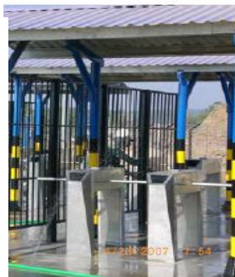
lắp đặt cổng điện tử
