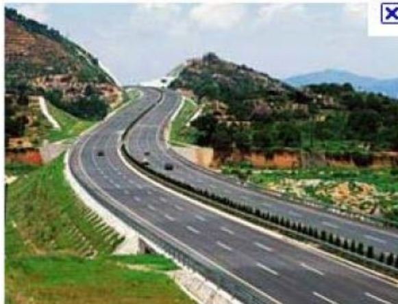
Dự án đường Cao tốc Nội Bài-Lào Cai
