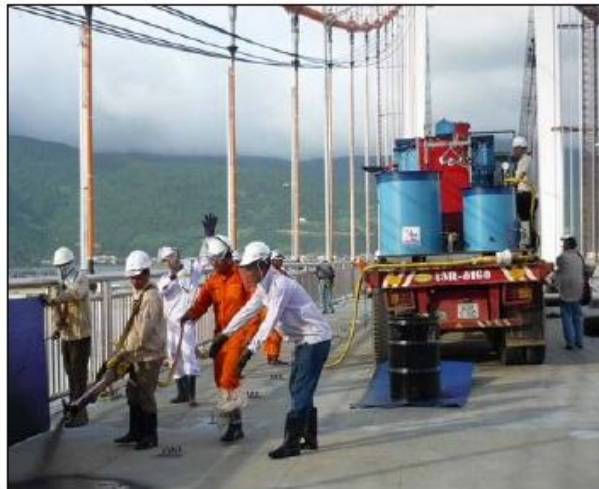
Thiết kế và thi công lớp phủ mặt cầu Thuận Phước, Đà Nẵng bằng BTN Epoxy.
