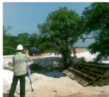
Khảo sát thiết kế cầu đường Dự án ADB5
