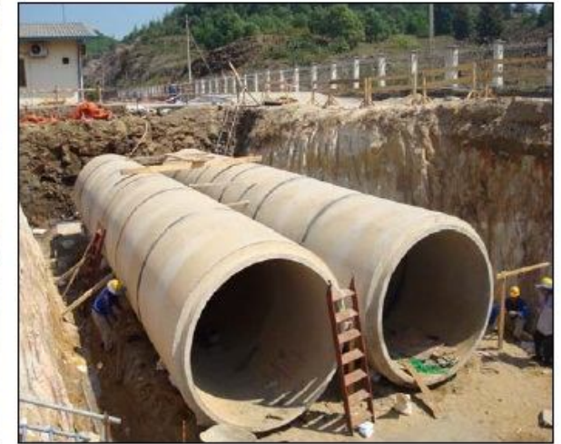
Thi công hệ thống ống thoát nước chính đường kính 2.4m trong Nhà máy Lọc dầu Dung Quất
