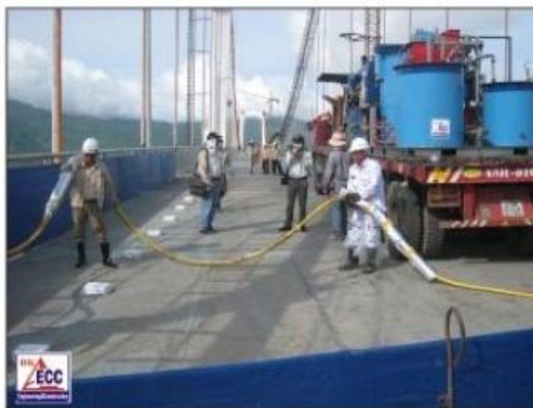
Phun nhựa Epoxy dính bám
