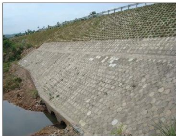
Bảo vệ mái dốc nền đường đắp cao trên tuyến tránh Đà Nẵng
