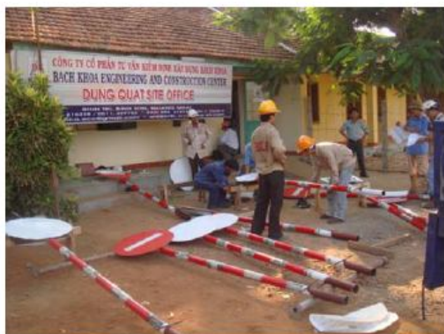
Chế tạo và cung cấp lắp đặt biển báo phân quang cho Công trường Nhà máy lọc dầu
