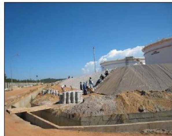
Ốp bảo vệ mái dốc để chắn bùn dầu khu vực Nhà máy lọc dầu số 1 Dung Quất
