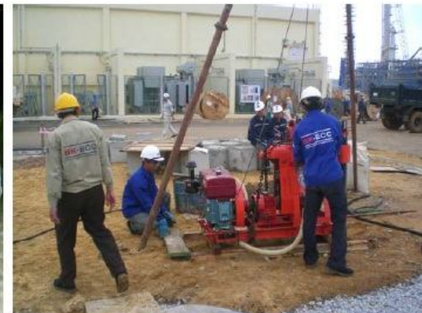
Khoan địa chất trong khu vực Nhà máy lọc dầu số 1 Dung Quất
