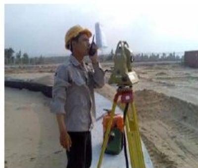
Trắc đạc kiểm soát thi công trình xây dựng.
