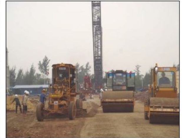
Đường tạm cho thiết bị nặng di chuyển trong Nhà máy Lọc dầu số 1 Dung Quất
