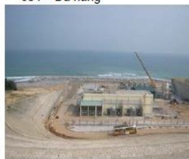
Bảo vệ mái dốc-Khu xử lý nước biển-NMLD Dung Quất
