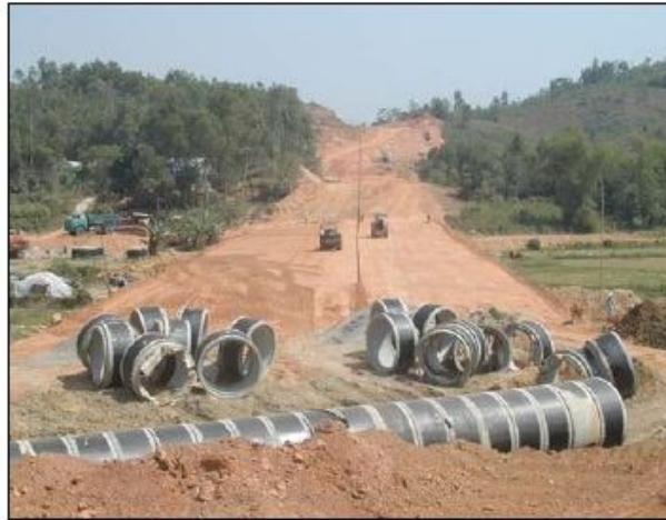
Đường và cống ngang trên tuyến tránh Bình Định, Quốc lộ 1A
